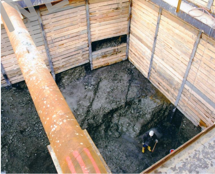
BOS019 CSO Storage Conduit – 670,000 gallons
