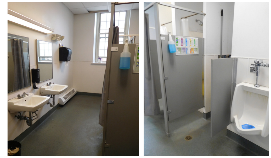
Non compliant Restroom
