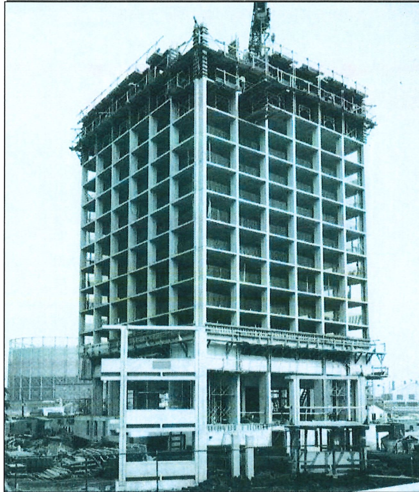
1966 photograph of Eastgate (# E55) under construction (MIT Museum).
