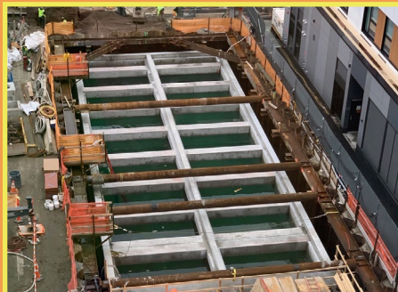
Tanque Parking Lot 6 Tank construído durante a Fase 1.
