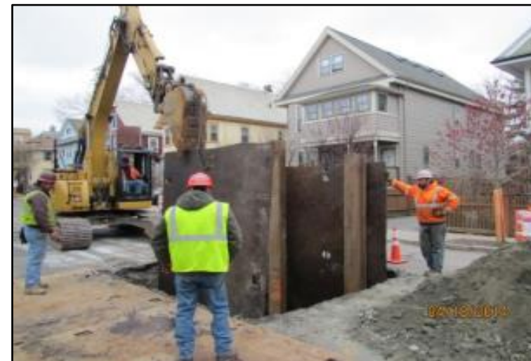
Separación de alcantarillas en Concord Ave, Cambridge
