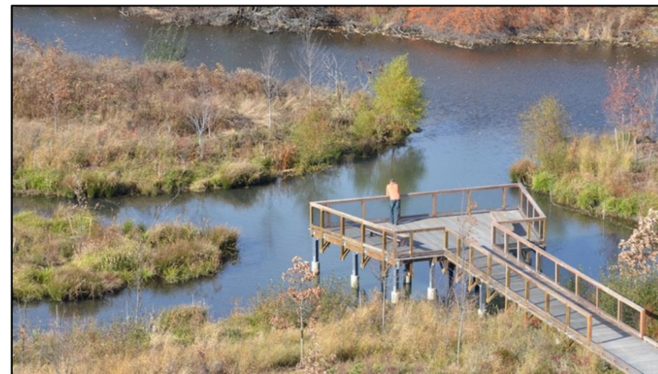
Humedal de aguas pluviales para gestionar los flujos de aguas pluviales separadas
